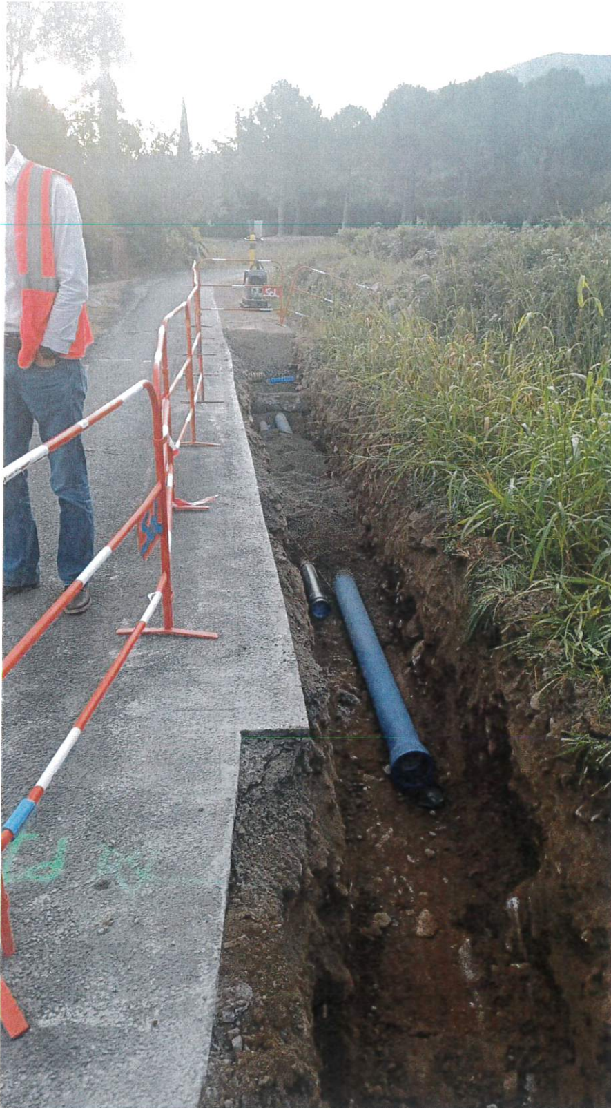
Figure 29 : chantier en cours
