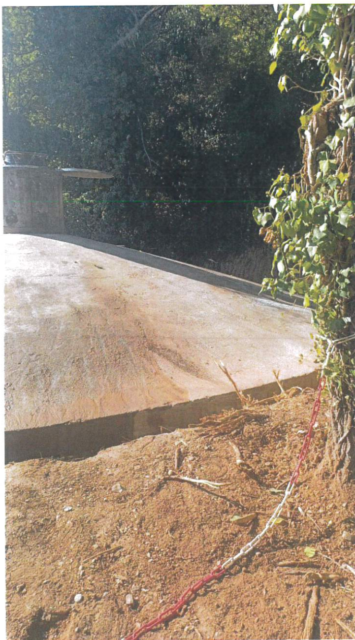
Figure 16 : toit en préparation
