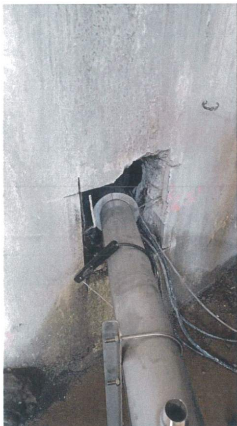
Figure 24 : traversées de voile en cours
