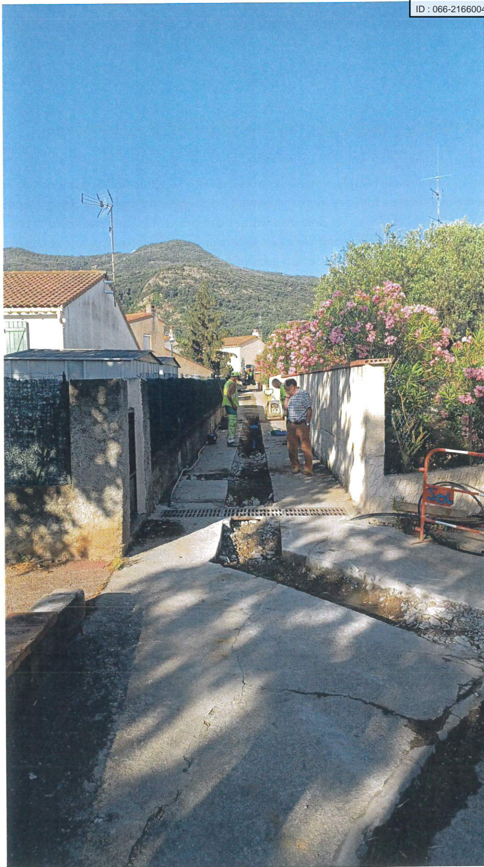
Figure 25 : chantier en cours
