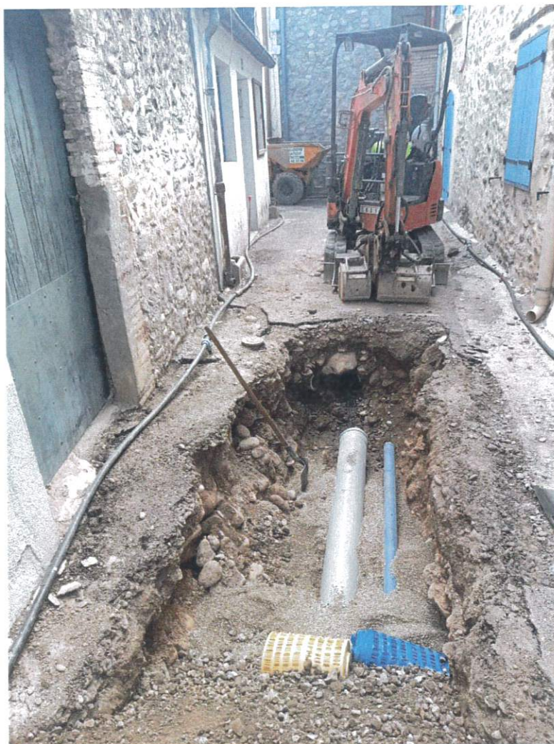
Figure 33 : travaux en cours
