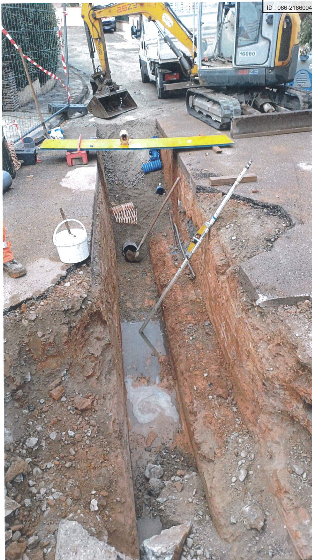
Figure 31 : chantier en cours
