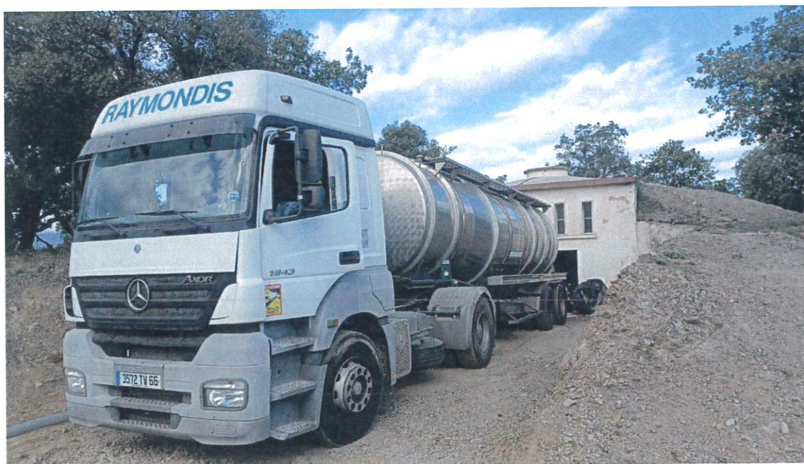
Figure 21 : cuve remplaçant le réservoir le temps des travaux
