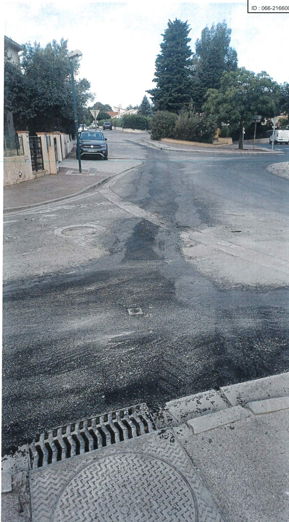
Figure 26 : réfection traversée du rond-point
