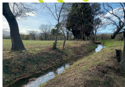
▮ Débit réduit de 50% pour le canal
