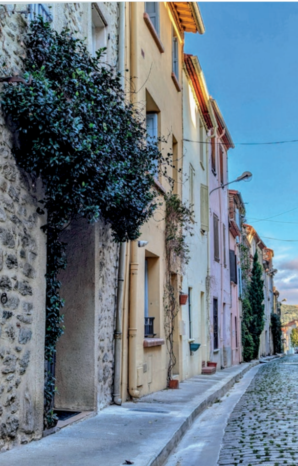
Des pieds de façade existants rue de la République
